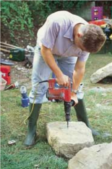
Die Störsteine mußten für die hochwassersichere Befestigung im Merzenbach mit passenden Bohrungen versehen werden. (Foto: Haug)
